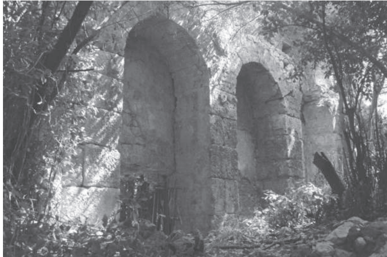
Res. 2 Küçük Hamam Kuzey Duvar
