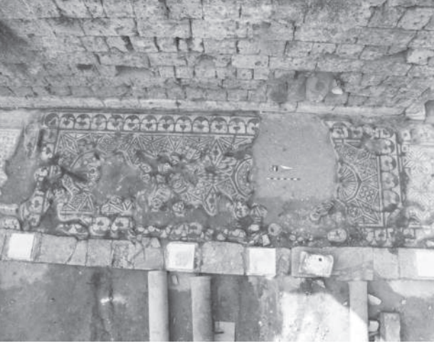
Res. 5 Güney Hamam palaestrası batı portik mozaiklerinin onarım sonrası durumu
