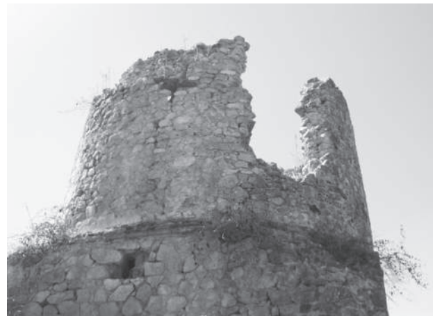
Res. 1 Ceyhan, İsalı Köyü, doğu girişi kule yapısı
