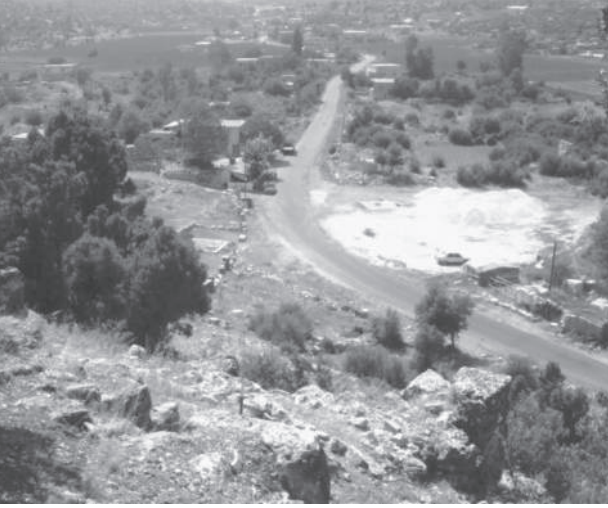
Res. 2 Olba Akropolisi Kuzey Yamacı Üzerindeki Kule Fig. 2 Olba, the acropolis and tower on the north slope
