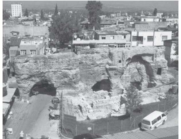
Res. 1 Tarsus Roma Hamamı güney cephesi (1 nolu duvar)
