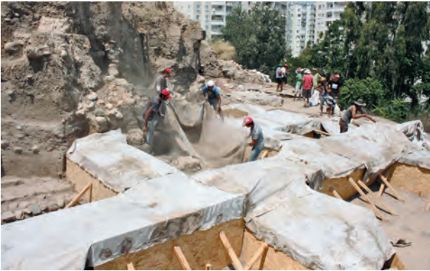
Res. 6 15. yy. sur duvarlarının koruma önlemleri ağaç levha ve jeotekstil örtü
