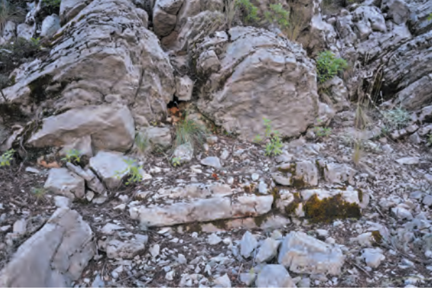
Res. 3 Anakayaya dayandırılmış yapılar Fig. 3 Buildings resting against the bedrock
